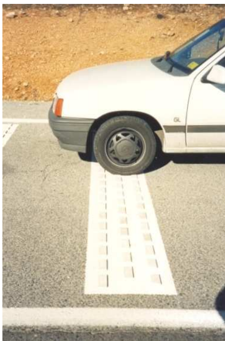
Colocación de los resaltes con la ayuda de una plantilla
