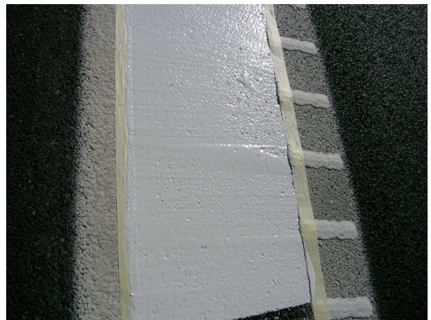
Extensión del material con zapatón
