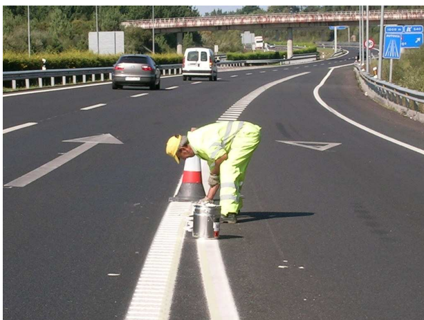
Extensión del material con llana
