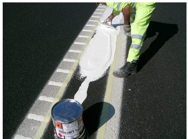
Extensión del material con llana
