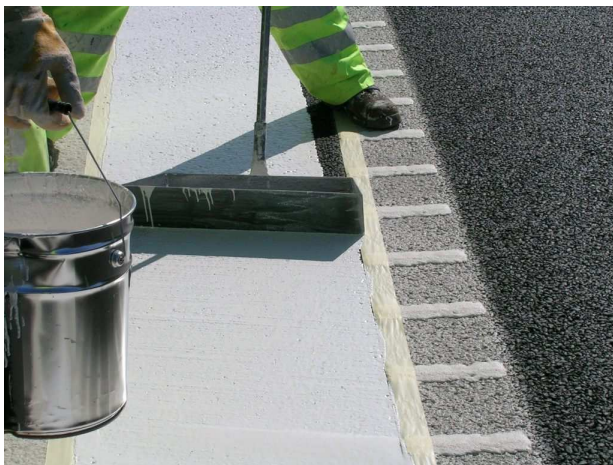
Extensión del material con zapatón
